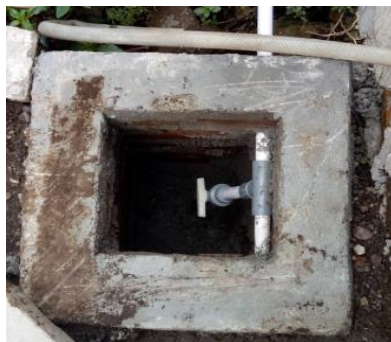
Pipa gas dari bak digester
