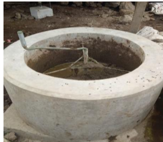
Bak Penampung kotoran
