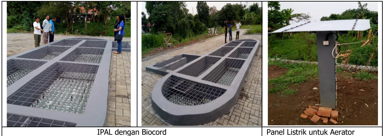
Gambar 9. IPAL Domestik di Sungai Cidadap DAS Citarum Kab. Karawang
